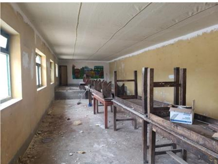
Note : le faux plafond a été réalisé selon la technique traditionnelle : une toile suspendue au plafond enduite de plâtre.
