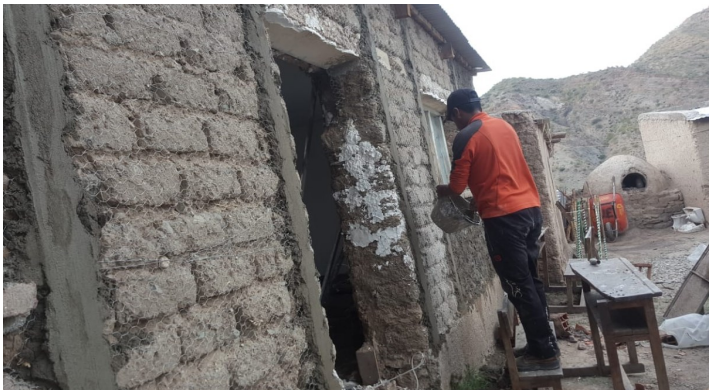
Mise en place de la gouttière du préau
