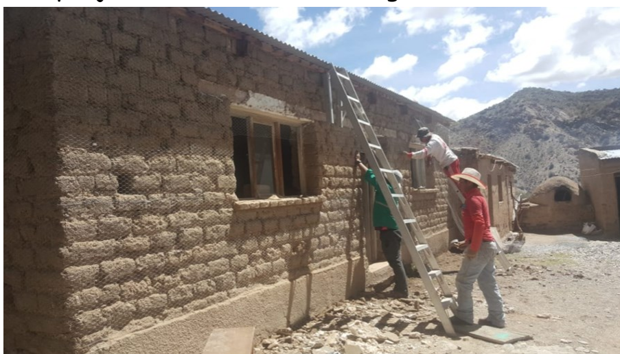
Réfection d'une salle de classe - Ecole de Lonte
